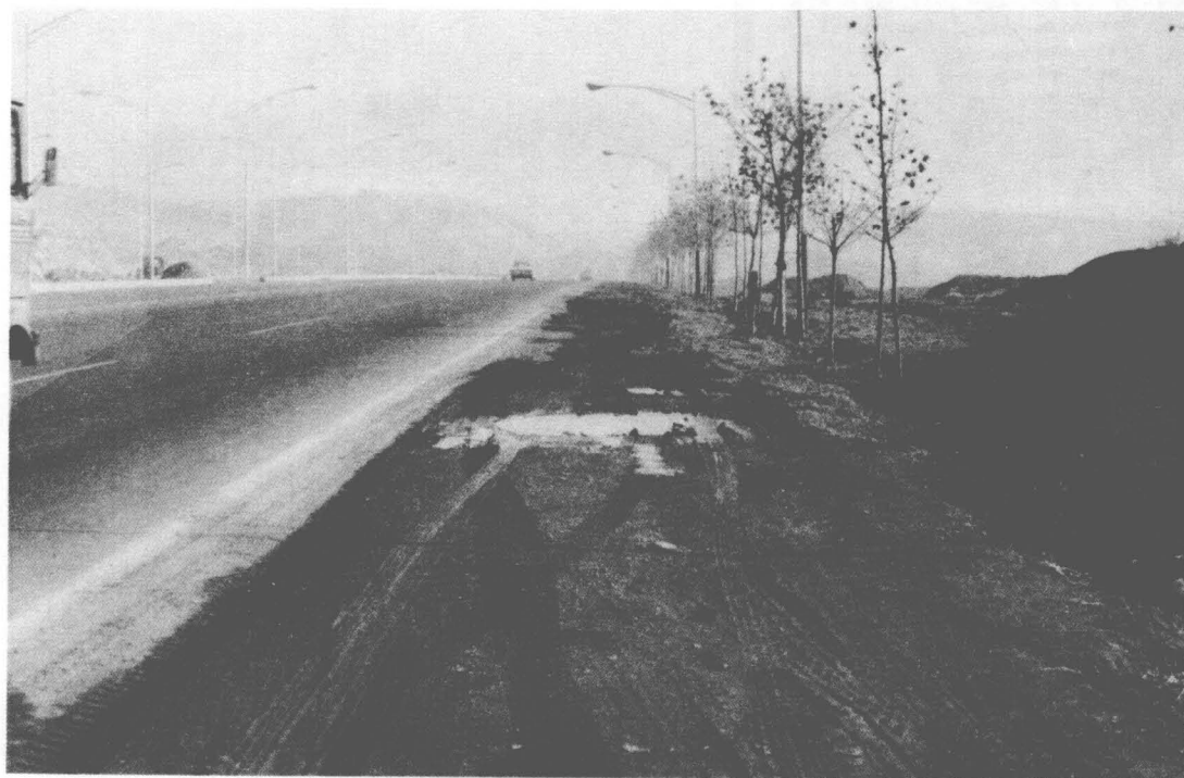
شکل ۱۰ - نمونه ای از خرابی شانه راه
