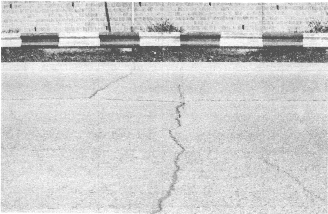
شکل ۴- نمونه ای از ترکهای سرمائی و ترک بین دو خط
