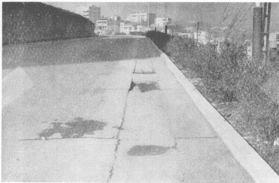
شکل ۵ - نمونه ای از نشست محل کنده کاری شده
