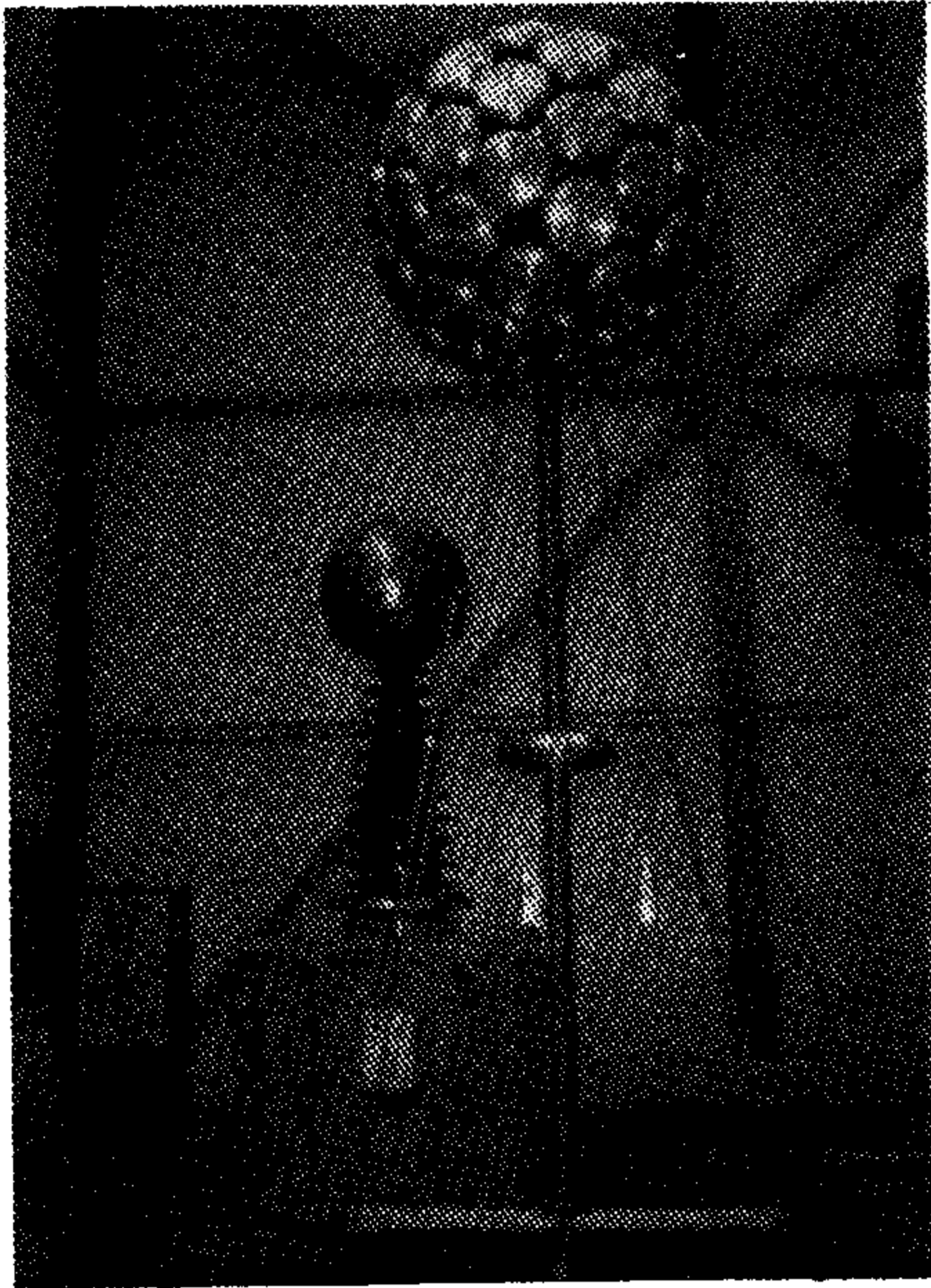
شکل ۴-ب: ترانسفورماتور آزمایشگاهی فشار قوی.
